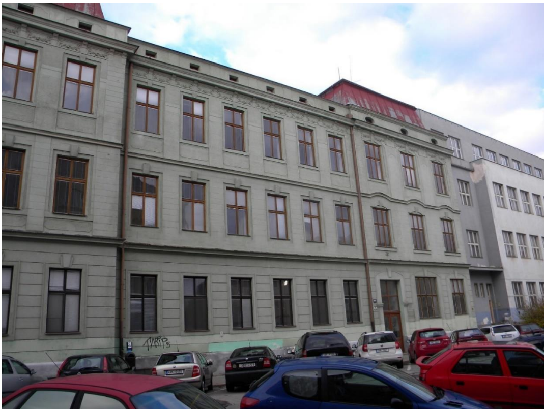
Obr. 1 Secesní část školní budovy na Alšově ulici ve Znojmě z roku 1909
