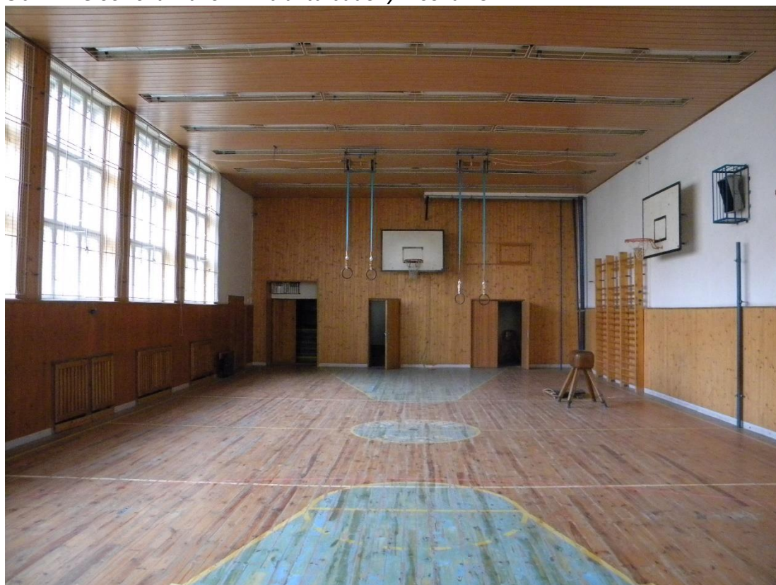
Obr. 4 Tělocvična v dvorním traktu budovy Alšova 15
