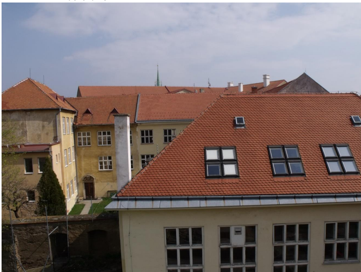
Obr. 12 Vlevo zadní trakt ZŠ Václavské náměstí, plynule přecházející v jihovýchodní trakt obchodní akademie. V popředí tělocvična z roku 1935, vlevo od ní stávala tzv. Židovská věž.
