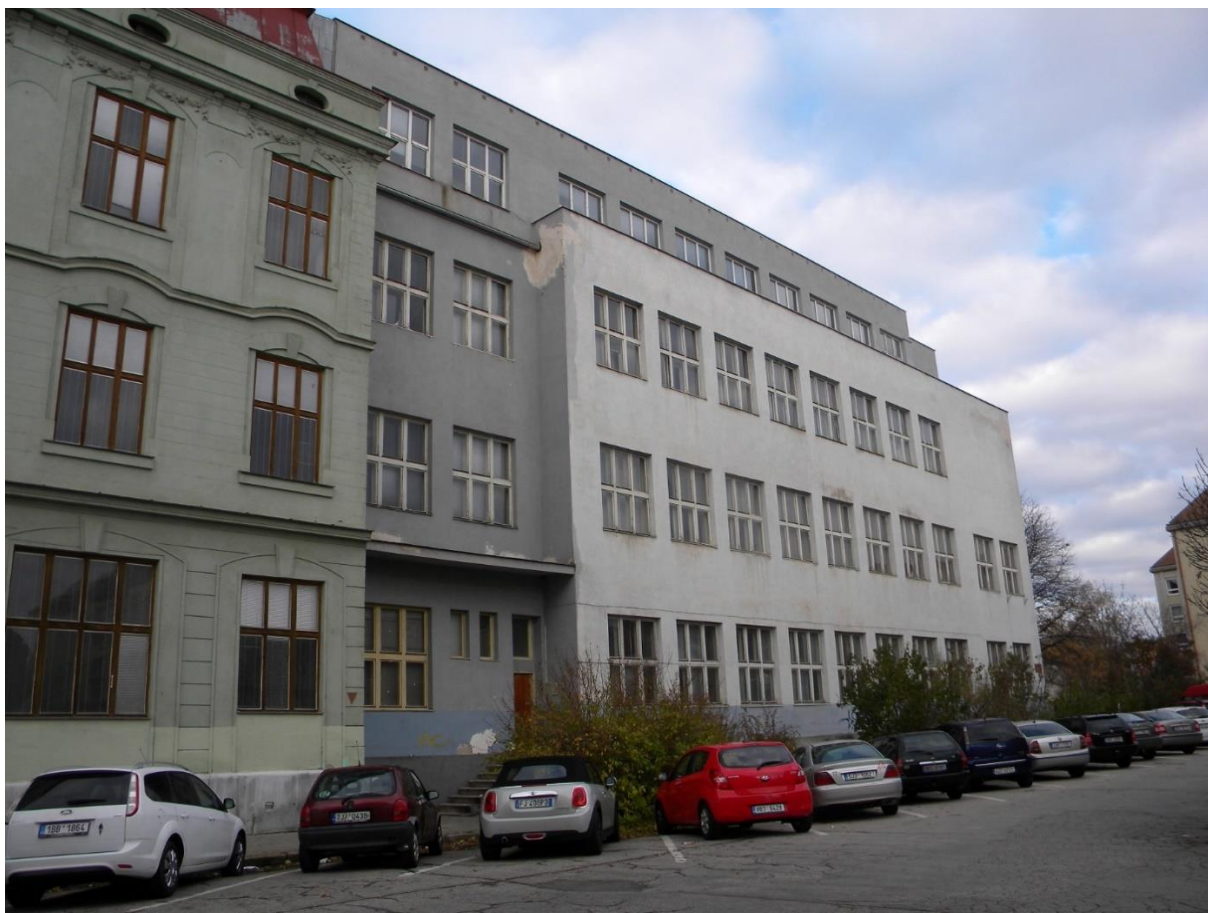
Obr. 2 Víškova funkcionalistická přístavba na Alšově ulici ve Znojmě z roku 1930. Horní uskočené patro je dodatečné, z konce 20. století
